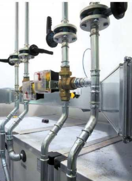
Fig. 15 - Instalación de calefacción industrial.
