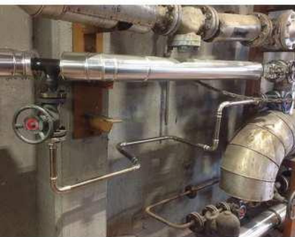
Fig. 28 - Instalación vapor saturado en la industria alimentaria
