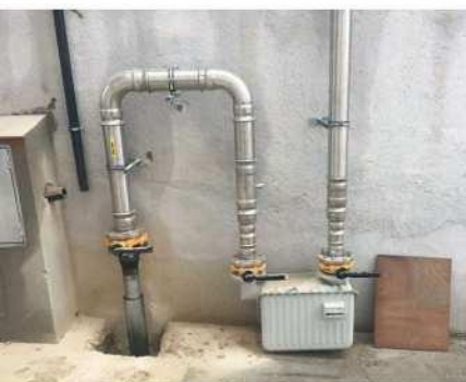
Fig. 23 - Instalación gas en industria.
