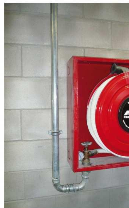
Fig. 17 - 18 Instalación de BIE's contra incendios.
