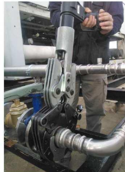
Fig. 57 - Prensadas con máquina UAP 100L medida Super Size.
