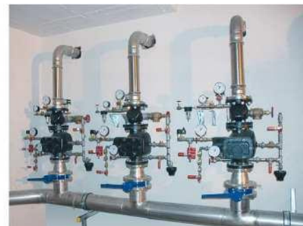
Fig. 11 - Instalaciones contra incendios
