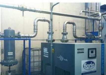
Fig. 8 - Instalaciones de aire comprimido
