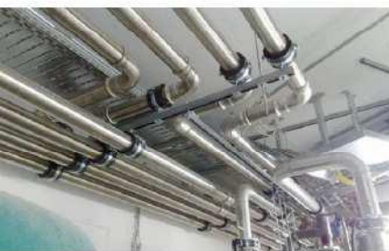
Fig. 4 - Instalaciones agua potable
