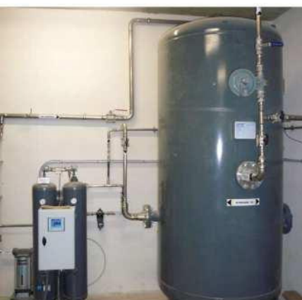
Fig. 7 - Instalaciones de gases inertes
