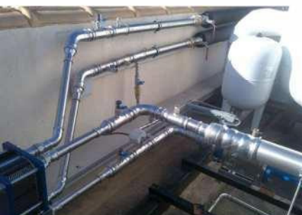
Fig. 6 - Instalaciones de climatización
