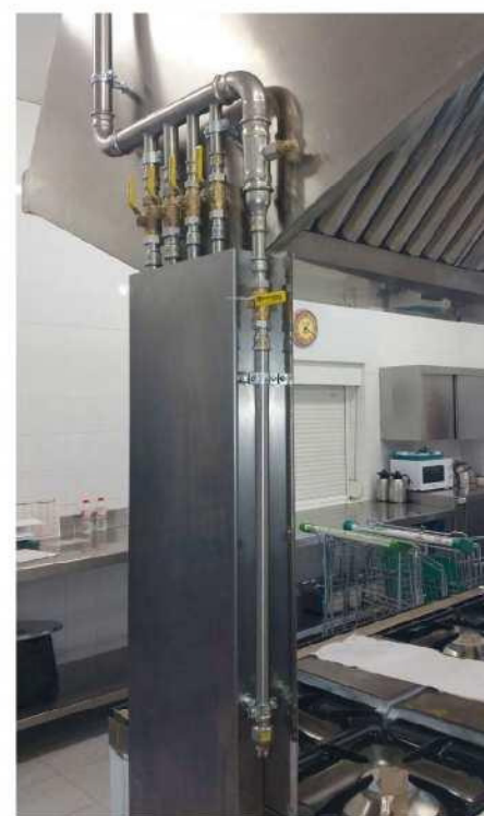
Fig. 24 - Instalación gas en cocina.
