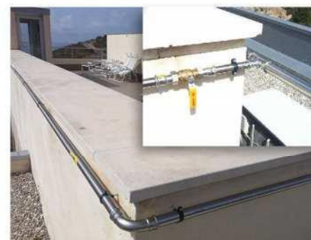
Fig. 25 - Instalación gas en apartamentos comunitarios
