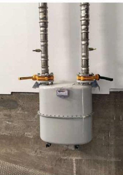
Fig. 21 - Instalación gas en nave industrial
