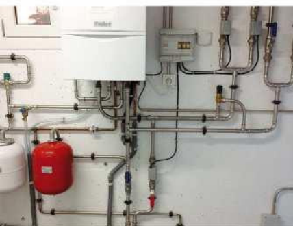
Fig. 5 - Instalaciones de agua caliente sanitaria
