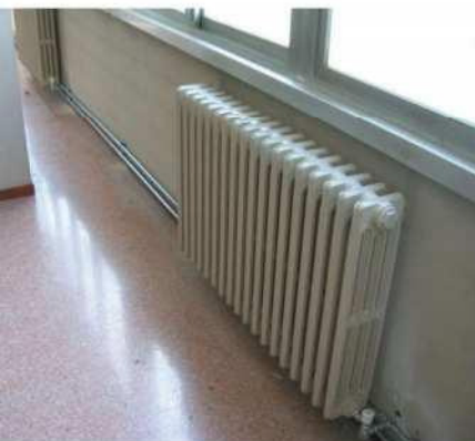
Fig. 16 - Instalación de calefacción por radiador.
