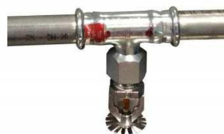
Fig. 19 - Instalación de splinkers contra incendios vía húmeda.
