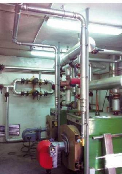
Fig. 22 - Instalación gas para quemadores en caldera industrial.
